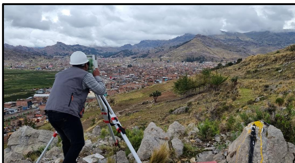
Foto N° 05: Ejecución de la poligonal topográfica de apoyo.
