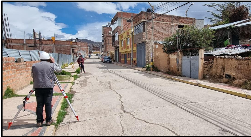
Foto N° 07: Levantamiento de la vía a los costados.
