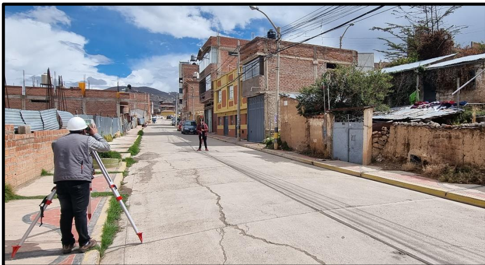
Foto N° 08: Levantamiento de la vía al eje.
