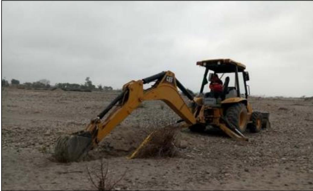
*Figura 10.* Excavación de calicatas con retroexcavadora
