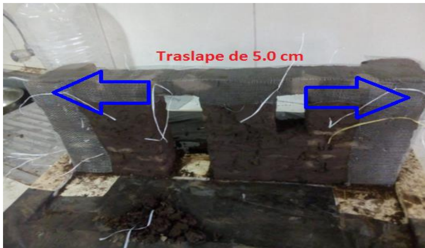
Figura 26. Muro con refuerzo de malla metálica.
