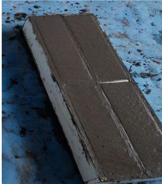
Fotografía 7. "Elaboración de viguetas de concreto"
