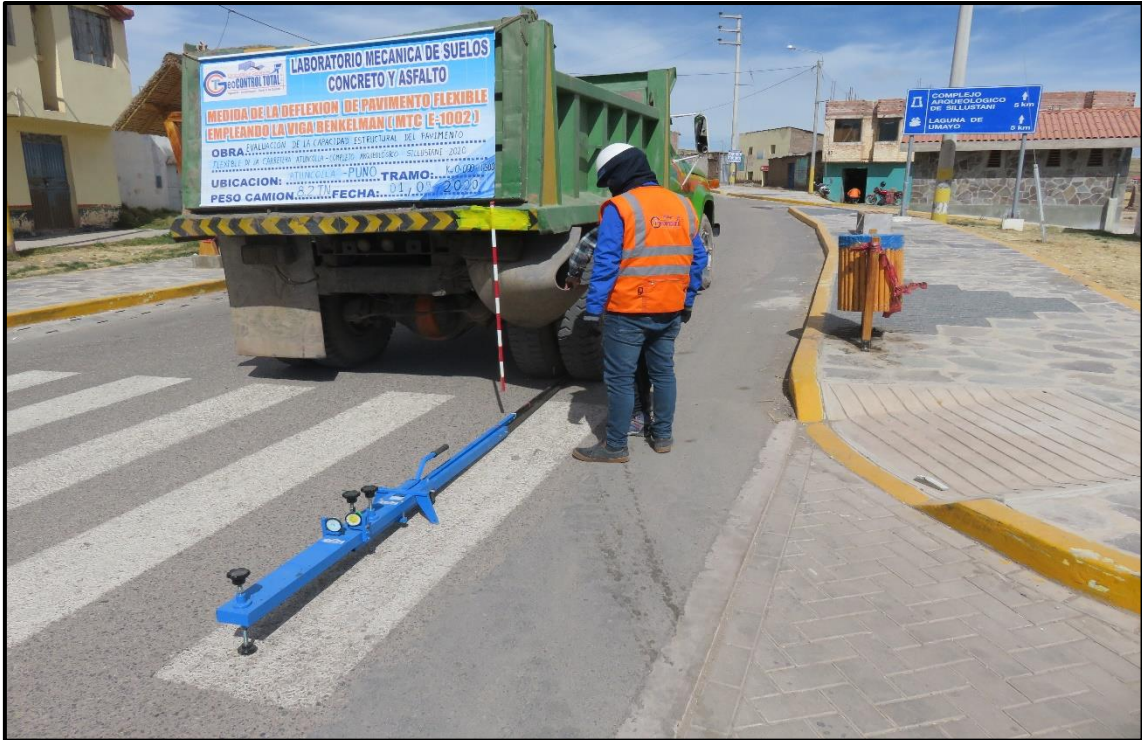
Figura 8: Acondicionamiento de la viga
