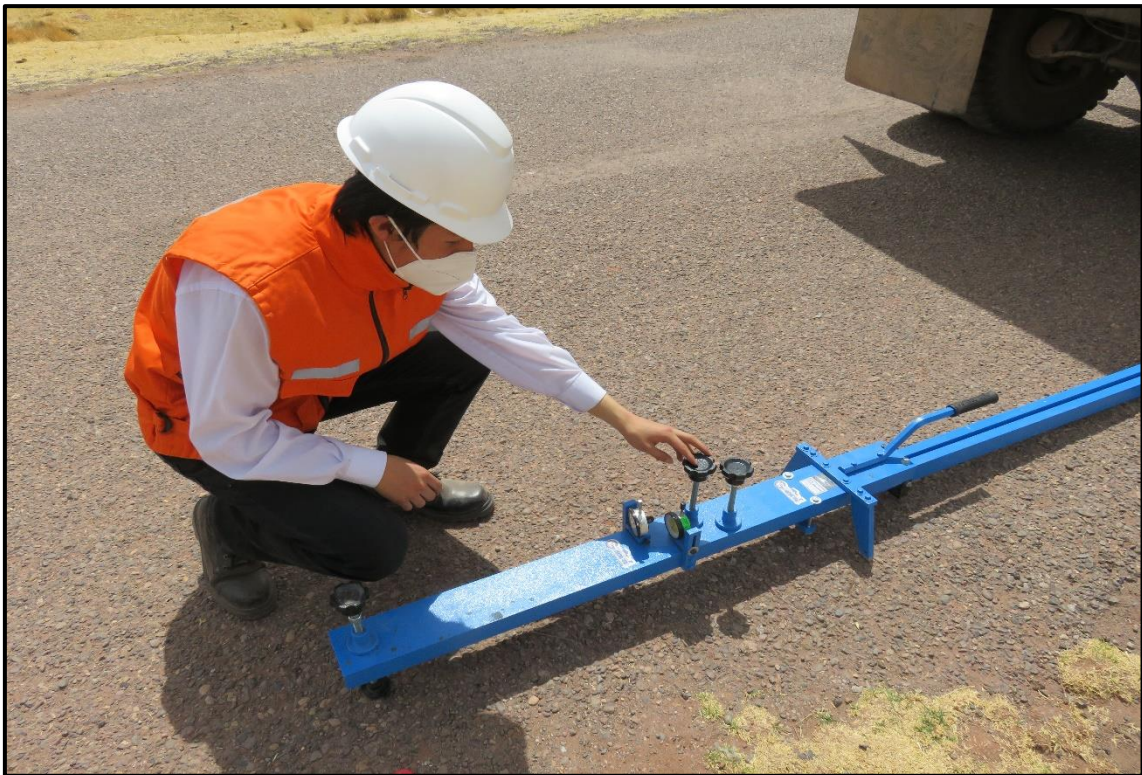
Figura 23: Nivelación de la Viga
