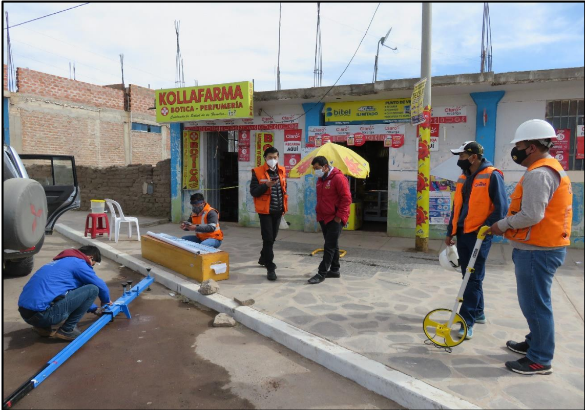
Figura 4: Armado de la Viga
