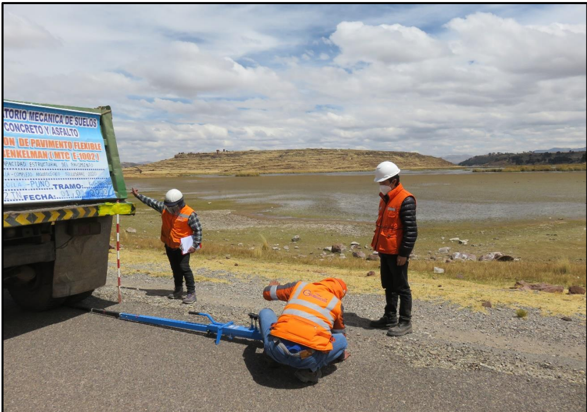
Figura 19: Nivelación de la Viga
