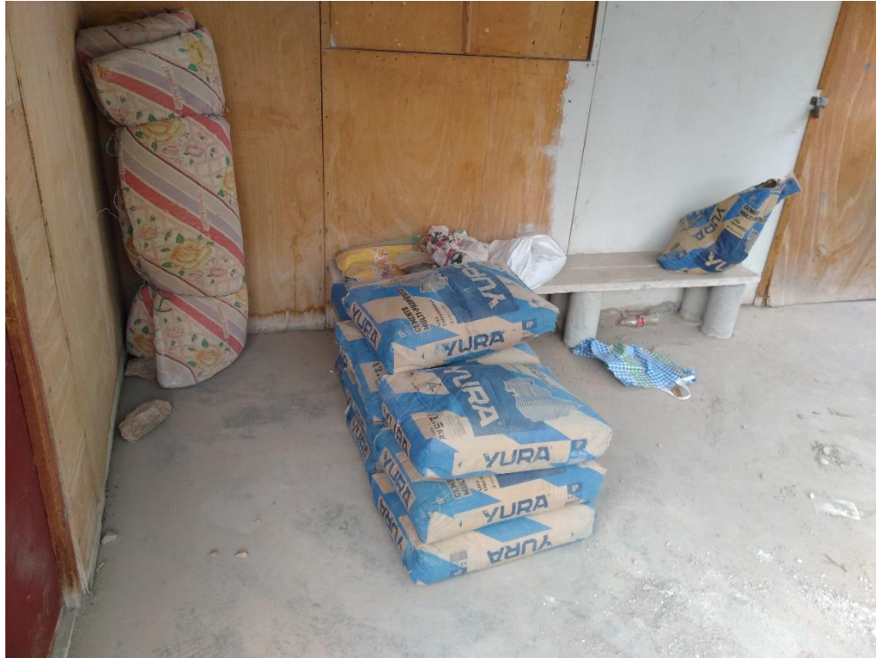
Figura 23: Almacenamiento del cemento.
