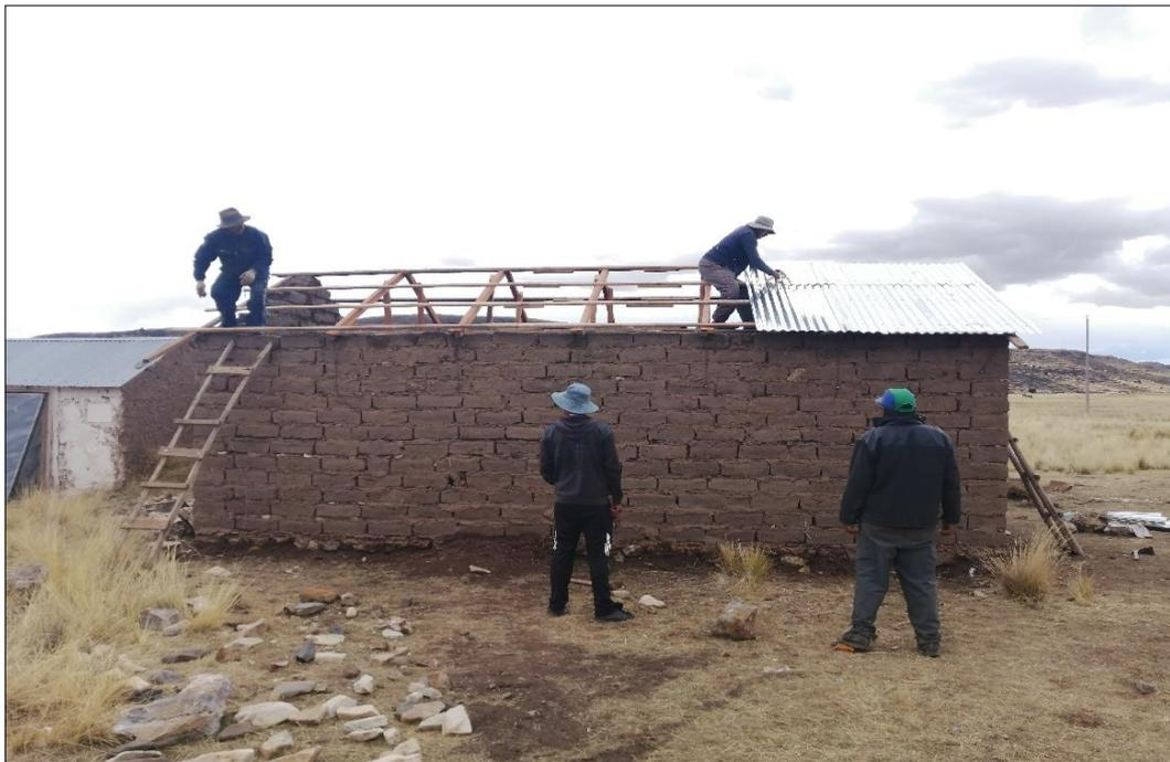
**Figura 18:** Proceso de puesta de calamina en una vivienda rural.
