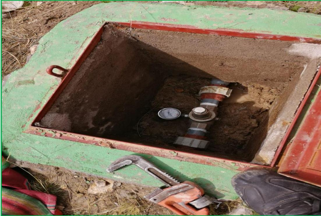
**Figura 14.** Válvula de control en la red de abastecimiento de agua potable Moquegache Central
