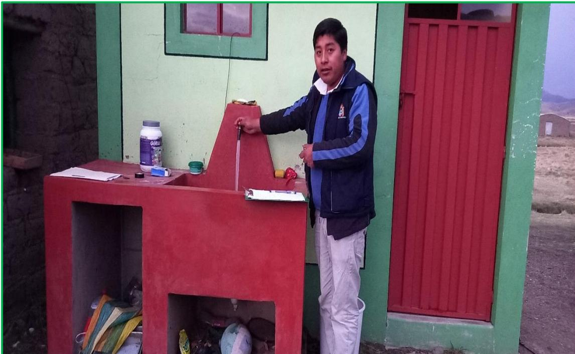
**Figura 15.** Observación del caudal en conexiones domiciliarias
