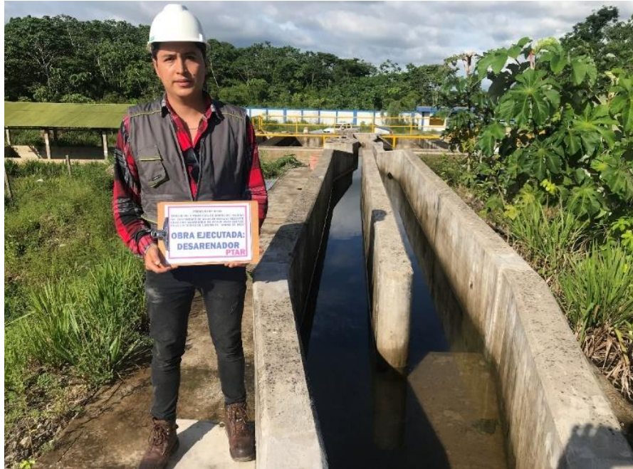
ANEXO 1.3: Desarenador “PTAR Laberinto” NOTA: Elaborado por el equipo de trabajo
