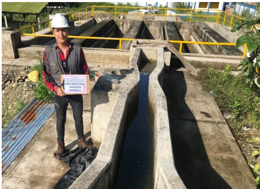
ANEXO 1.4: Canal Parshall “PTAR Laberinto” NOTA: Elaborado por el equipo de trabajo
