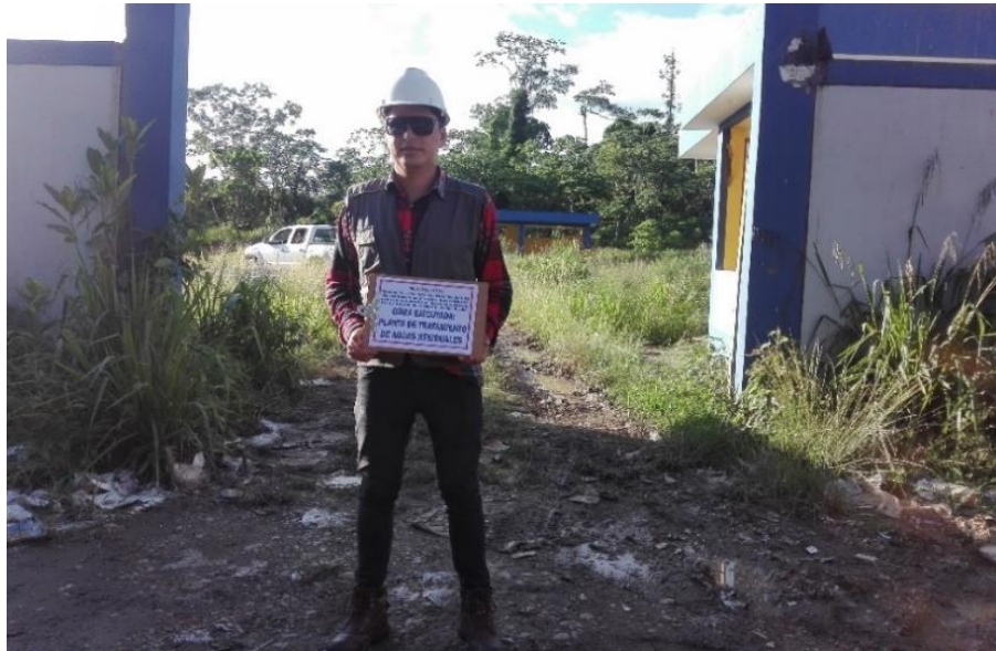
ANEXO 1.1: Entrada de acceso a la “PTAR Laberinto” para su respectivo análisis de diseño NOTA: Elaborado por el equipo de trabajo
