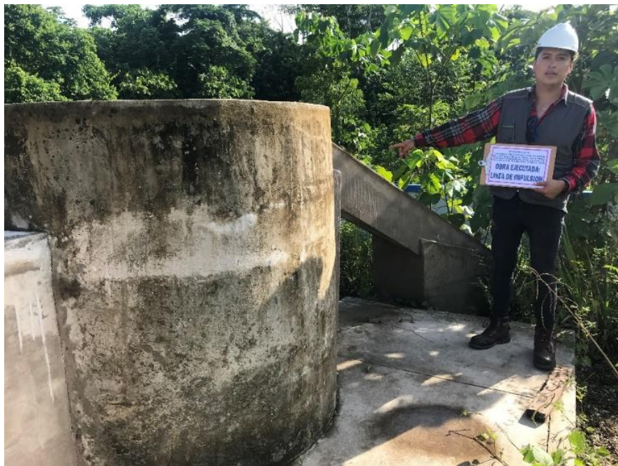
ANEXO 1.2: Línea de impulsión “PTAR Laberinto” NOTA: Elaborado por el equipo de trabajo
