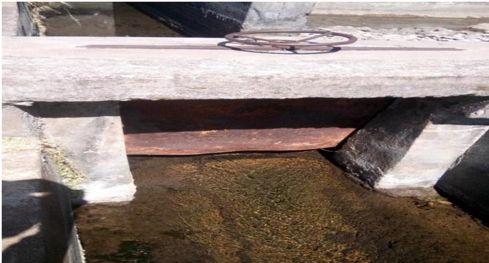
*Figura 8.* Compuerta de distribución del canal de derivación sistema de riego Pampamarca Tinta
