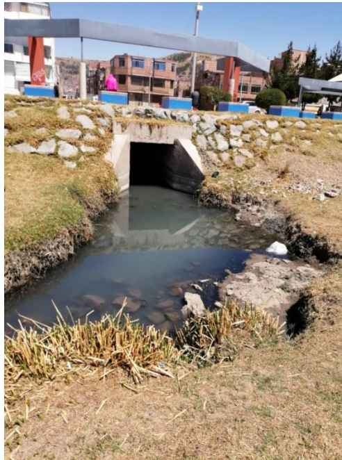
Fotografía 13. Toma de muestra del afluente barrio Bellavista
