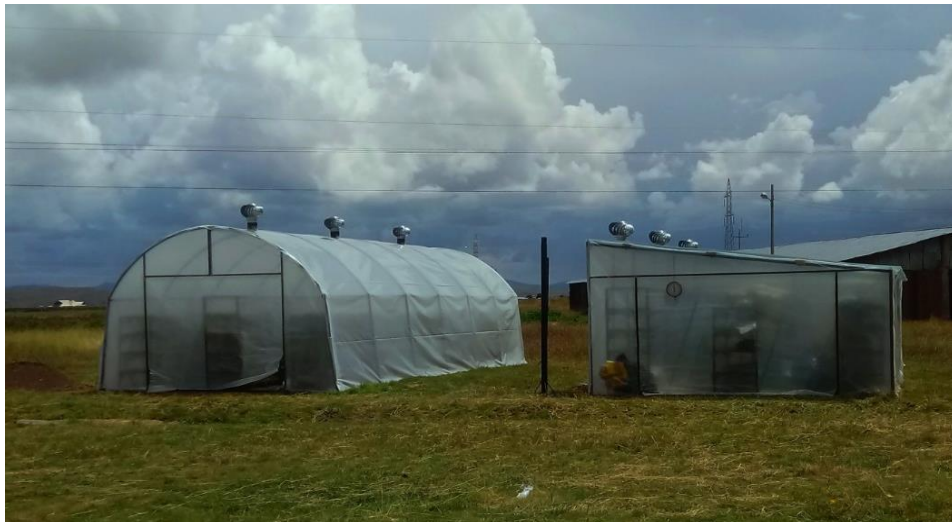
Figura 18 A4. Secador solar media agua y secador solar tipo túnel
