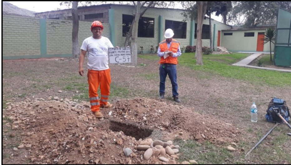
FIGURA 24: investigación del subsuelo a través de excavación de calicatas.
