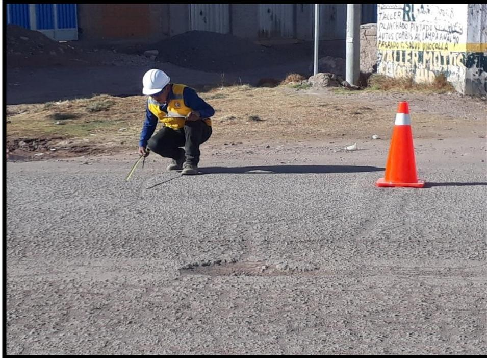
***Descripción: EN LA FOTO SE APRECIA FALLAS DE PELADURA POR INTEMPERISMO EN NIVEL DE SEVERIDAD MEDIO Y BAJO, EN EL TRAMO I***
