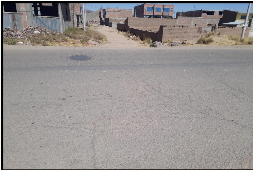
***Descripción: EN LA FOTO SE APRECIA FALLAS DE FISURAS EN BLOQUE EN NIVEL DE SEVERIDAD MEDIO, EN EL TRAMO I***
