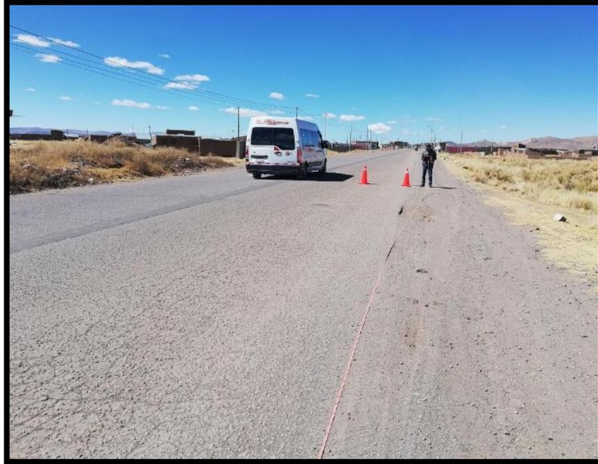
***Descripción: EN LA FOTO SE APRECIA PELADURAS EN NIVEL DE SEVERIDAD MEDIO, EL TRAMO III***
