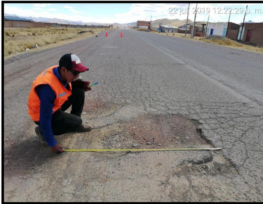
***Descripción: EN LA FOTO SE APRECIA BACHES EN NIVEL DE SEVERIDAD ALTO Y MEDIO, EL TRAMO III***
