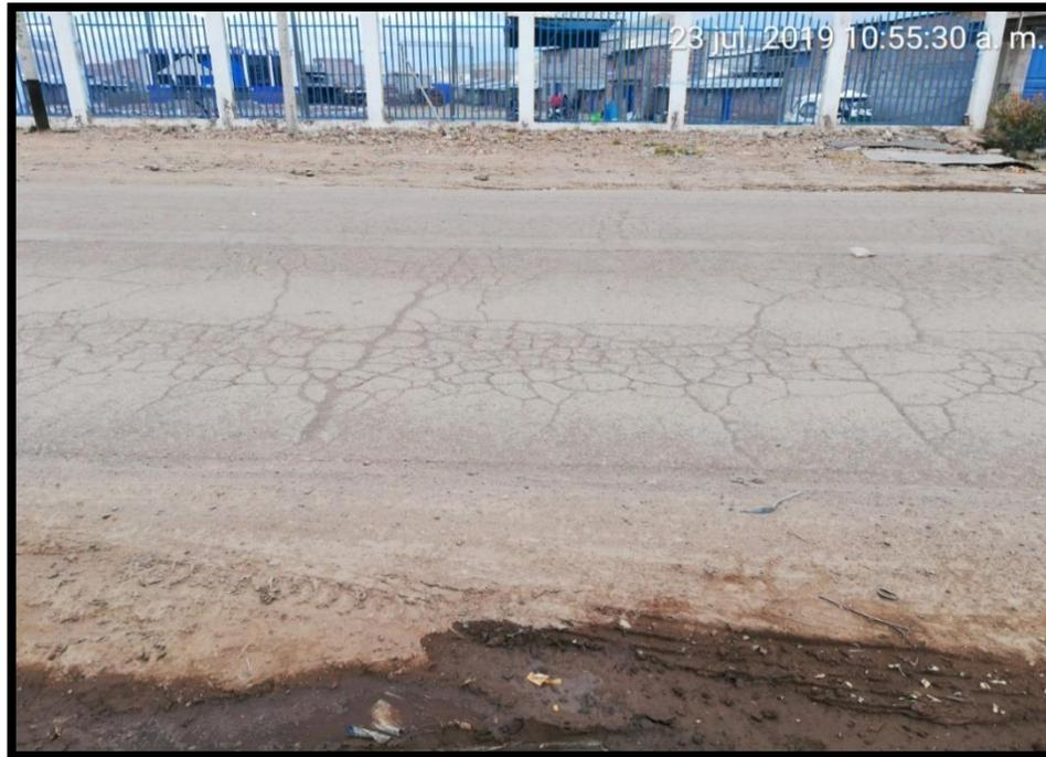
***Descripción: EN LA FOTO SE APRECIA FALLAS DE FISURAS EN BLOQUE EN EL NIVEL DE SEVERIDAD MEDIO, EN EL TRAMO II***
