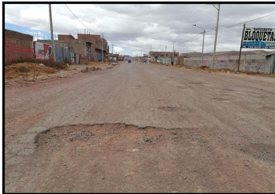
***Descripción: EN LA FOTO SE APRECIA BACHES EN EL NIVEL DE SEVERIDAD ALTO Y MEDIO, EN EL TRAMO II***
