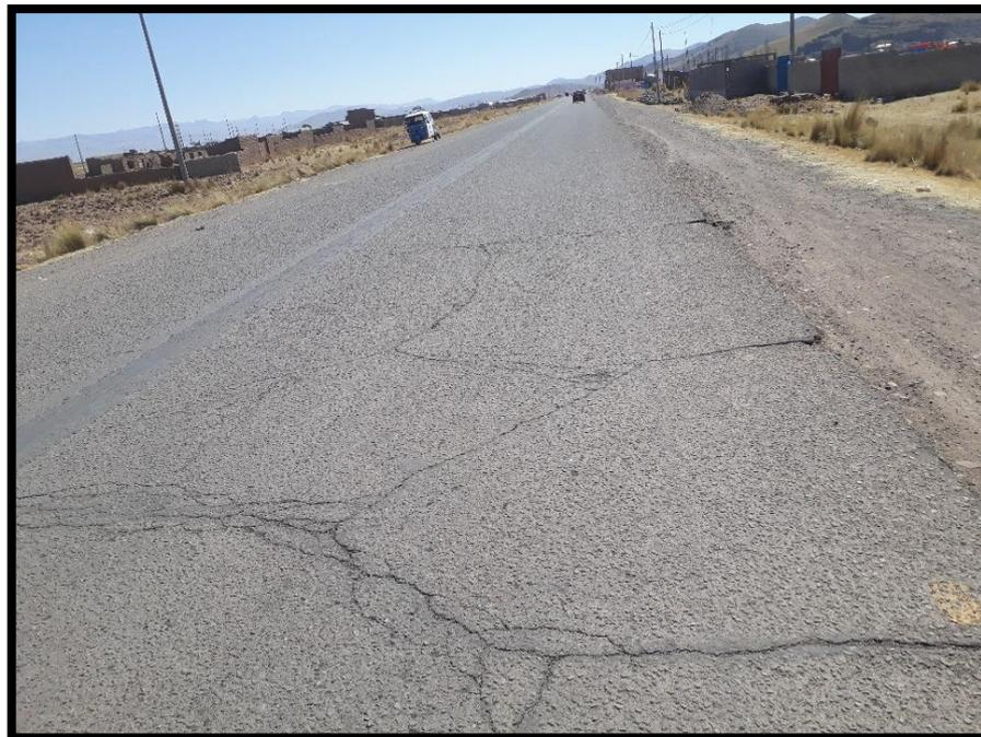
***Descripción: EN LA FOTO SE APRECIA FALLAS DE FISURAS EN BLOQUE EN NIVEL DE SEVERIDAD MEDIO, EL TRAMO III***
