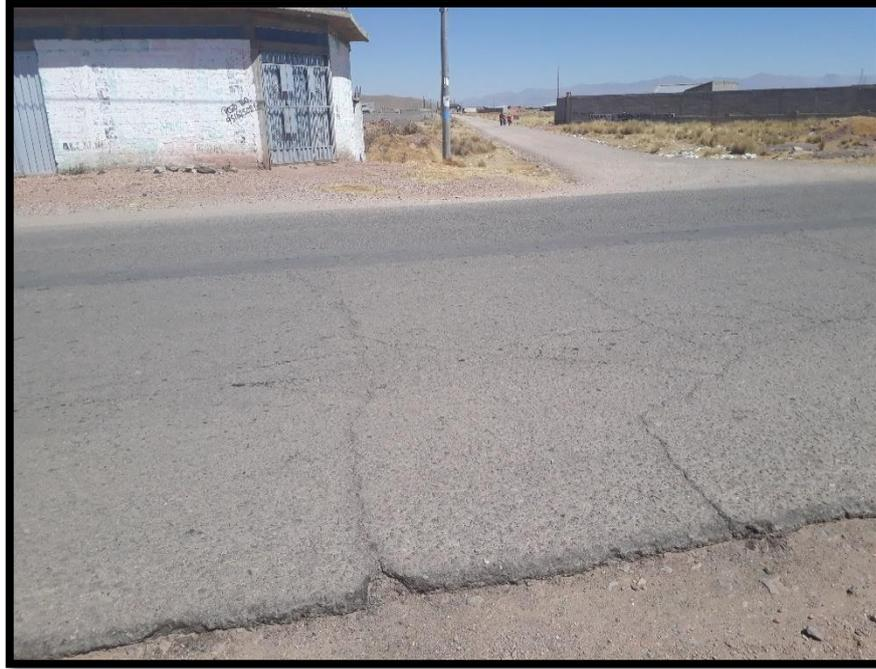
***Descripción: EN LA FOTO SE APRECIA FISURAS TRANSVERSALES EN EL NIVEL DE SEVERIDAD MEDIO Y BAJO, EN EL TRAMO II***
