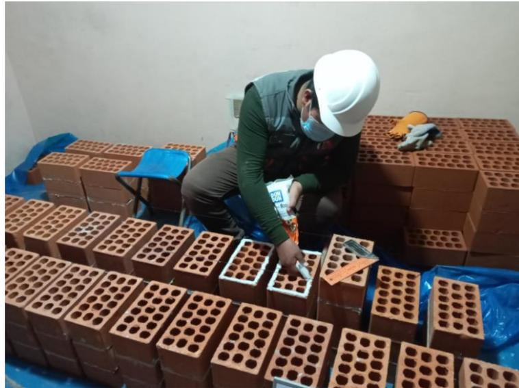
*Nota.* Aplicación de la Massa DunDun con juntas menores iguales a 3mm en superficie seco, según ficha técnica del producto. Fuente: Elaborado por el equipo de trabajo.
