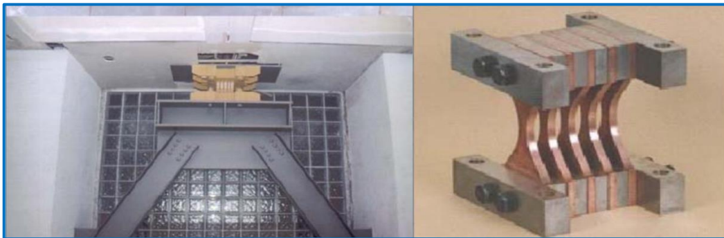
Disipador Tipo ADAS y Ubicación de Disipadores
