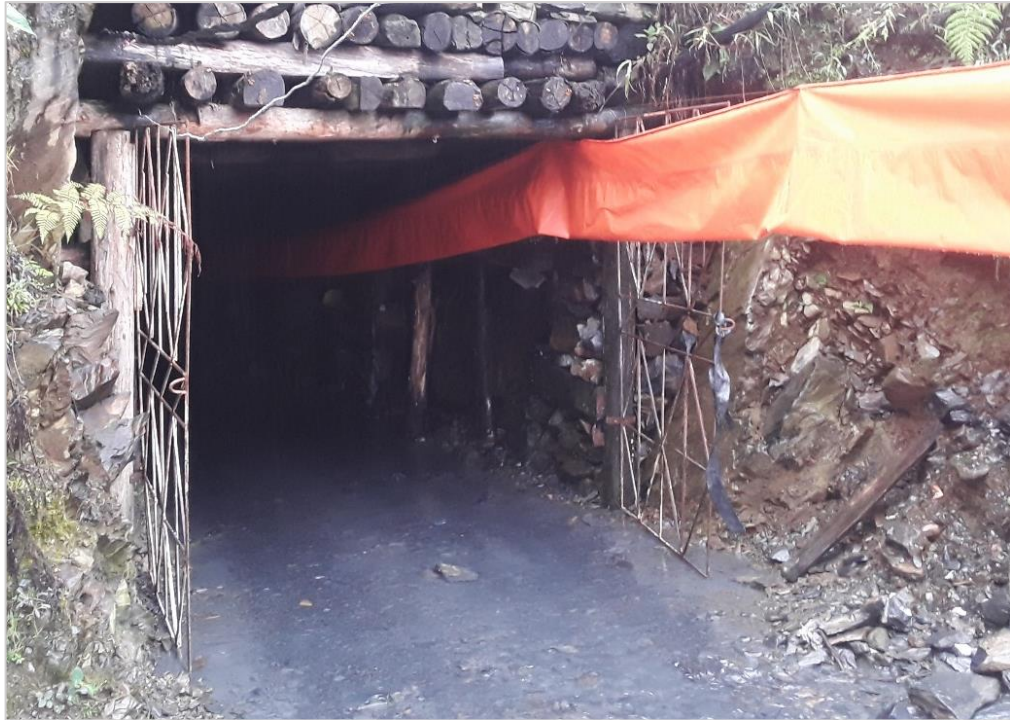
Figura 9. Bocamina de Unidad Media Naranja N°1000 - CIA Minera Ayapata S.A.
