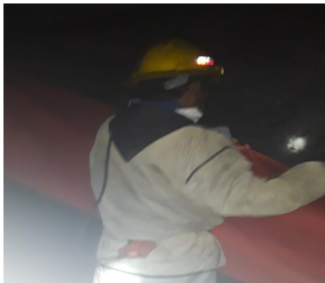
Figura 12. Colocación de mangas de ventilación interior mina.
