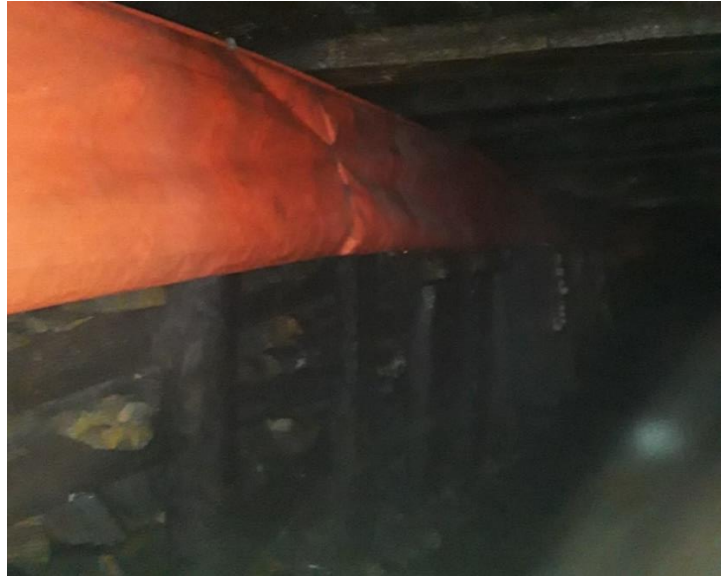
Figura 11. Sosténimiento convencional realizado en la Unidad.
