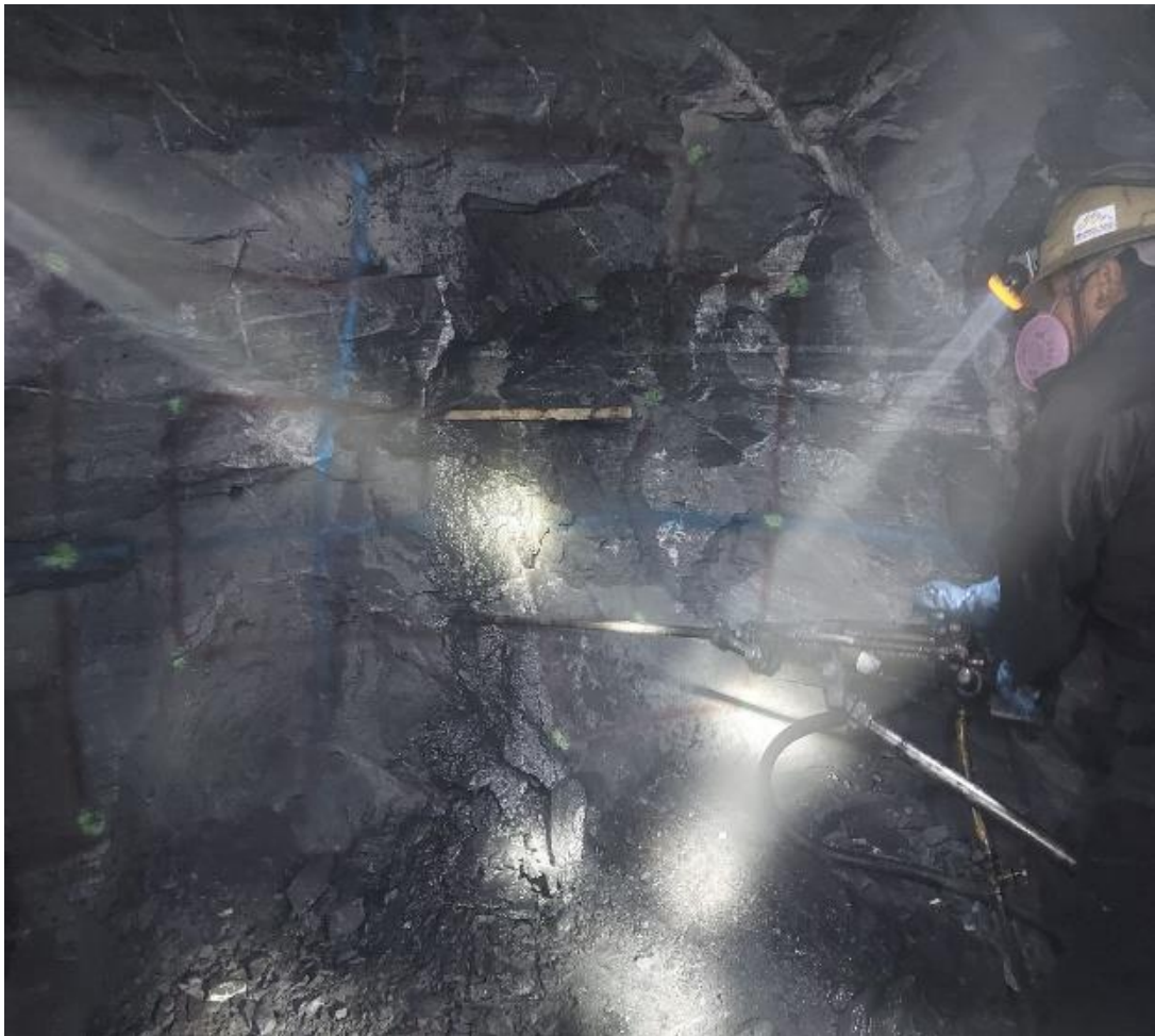
Figura 19. Posición inicial de la máquina perforadora.
