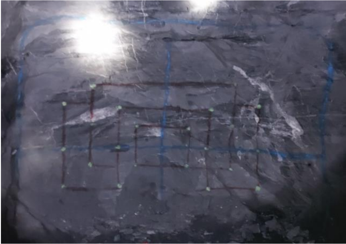
Figura 17. Pintado de la sección, dirección, gradiente y malla de perforación.
