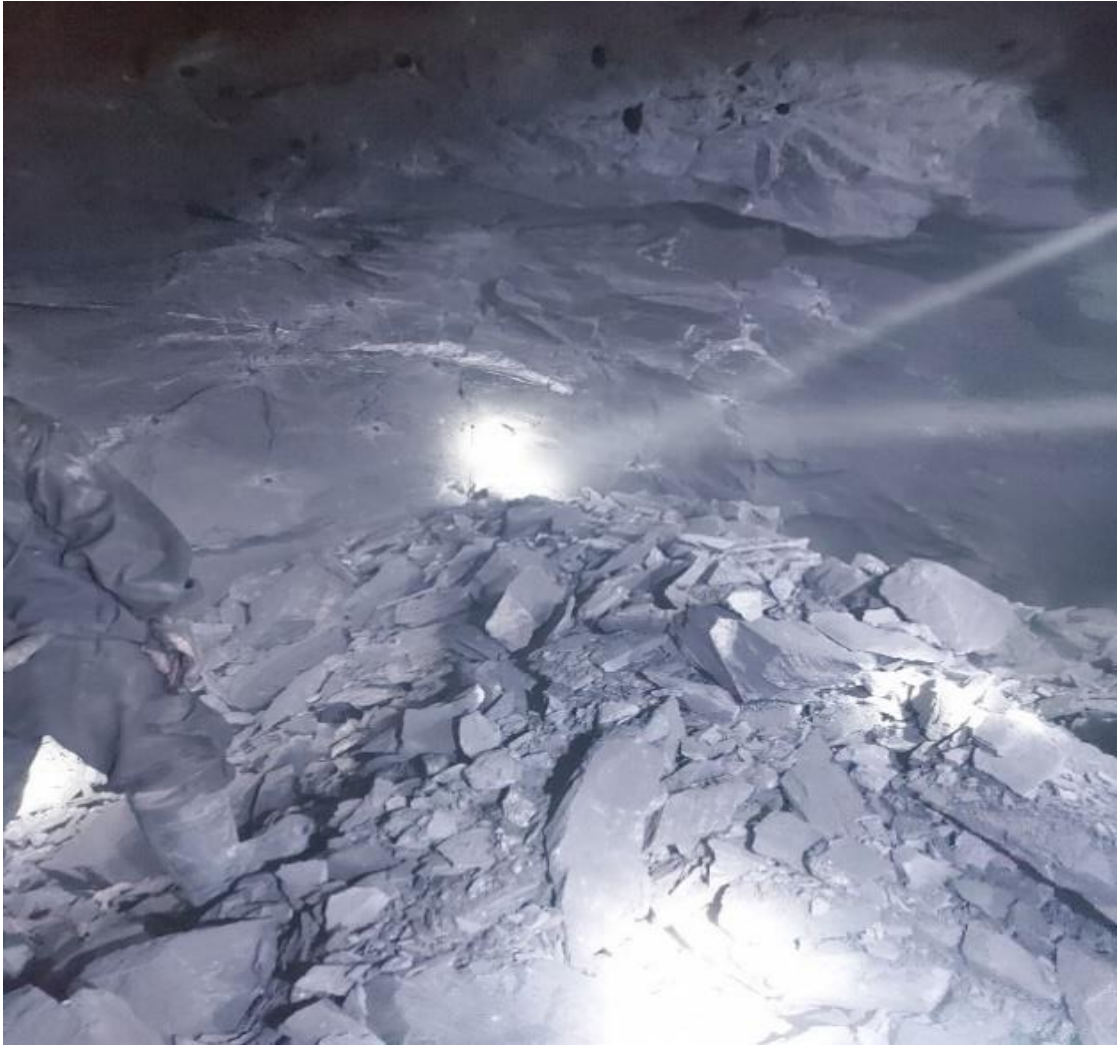
Figura 23. Resultado después de la voladura, aplicando el corte en "V".
