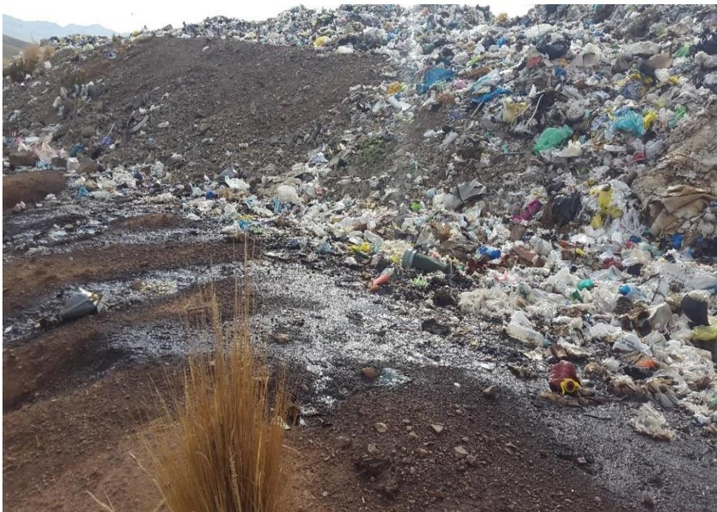
*Figura 24.* Lixiviación de RSU en disposición final de Cancharani Puno
