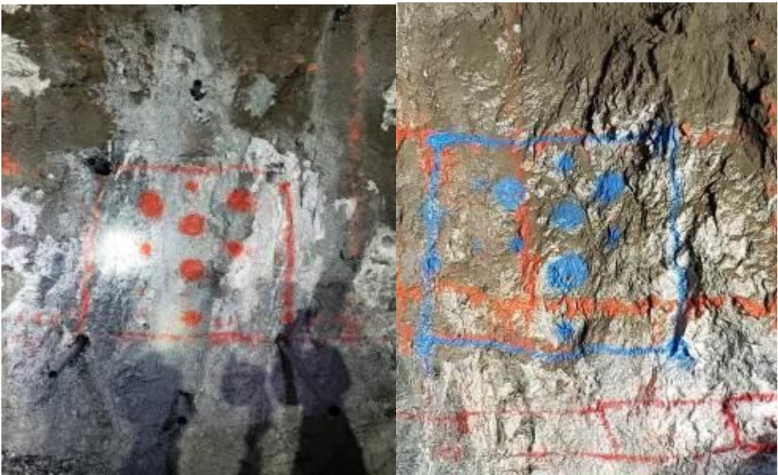
Anexo 4. Malla de perforada según diseño sección 4.50 x 4.00m.
