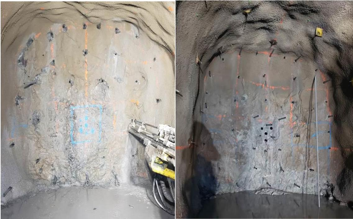
Anexo 5. Longitud de perforación, selección de Faneles adecuados para el arranque.
