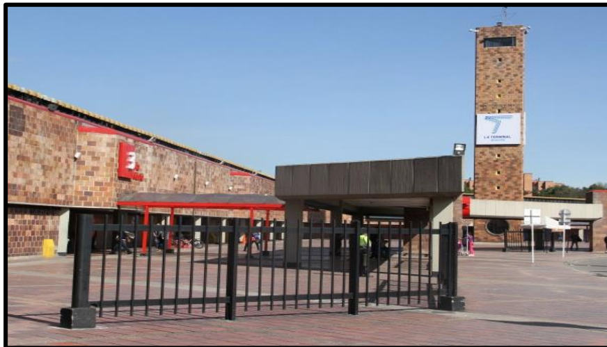
Figura 0-12 Terminal Terrestre de Bogotá Fuente: http://www.terminaldetransporte.gov.co/la-terminal-de-transporte-de-bogota-se-prepara-para-conmemorar-puente-festivo-de-la-batalla-de-boyaca/
