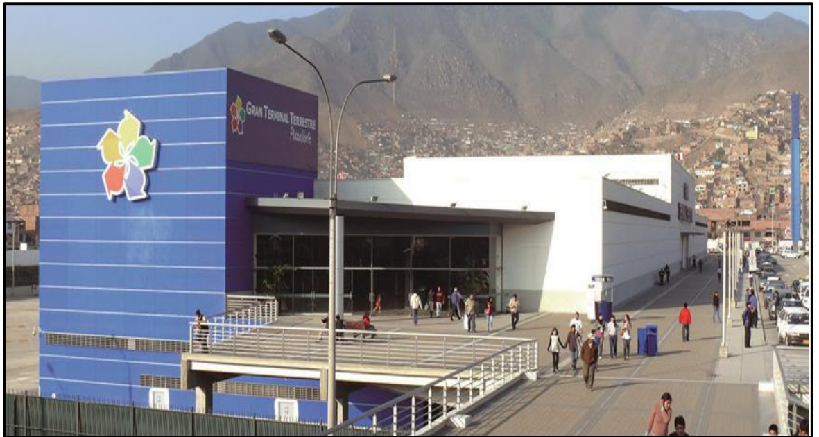
Figura 0-16 Vista desde el puente que conecta con el centro comercial Plaza norte Fuente: Carlos Chinen Arquitectos & Consultores.
