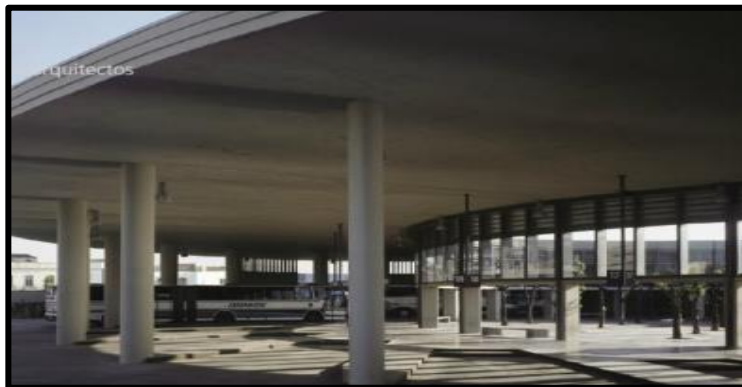
Figura 0-4 Aspecto estructural de la Estación de Buses Hueva
