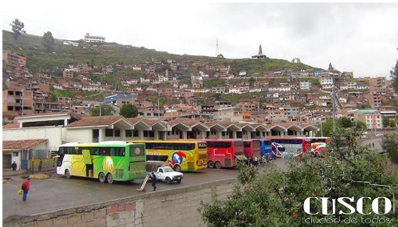
Figura 0-22 Cubiertas techadas a dos aguas en el terminal terrestre de Cusco
