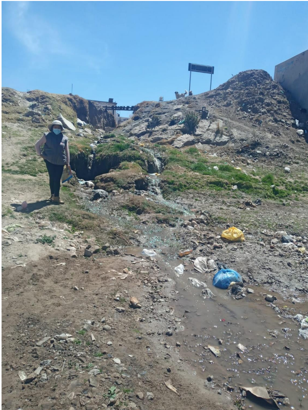
Figura A.9: De Magaly Roque. En la figura se muestra aguas residuales que ingresan al cauce del río Coata.
