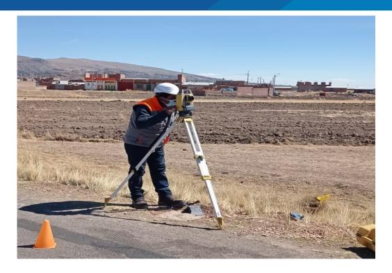
Figura 38. Medición de distancia con Estación Total Topcon
