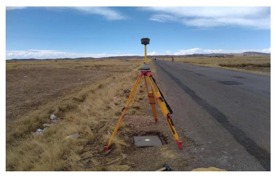
Figura 35. Instalación de puntos de control geodésicos PCG-02
