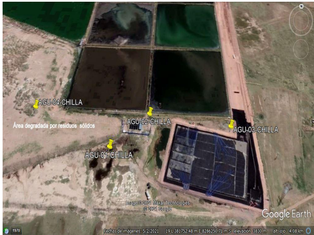
Figura 9. Puntos de monitoreo del agua con lixiviado (AGU-01-CHILLA, AGU-02-CHILLA y AGU-03-CHILLA); monitoreo de lixiviado (AGU-04-CHILLA) en el ámbito del Botadero de residuos sólidos de Chilla
