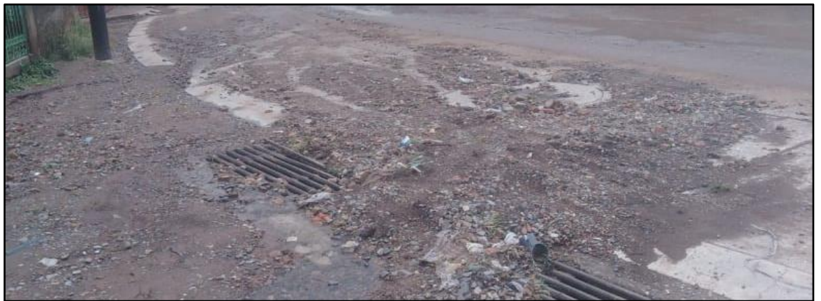
Figura 19: Arrastre de material no consolidado por lluvias, parte baja de la Microcuenca Llavini, esquina entre Jr. Panamá y Jr. Los Laureles, E: 390381 y N: 8250488. Fuente: Propia.
