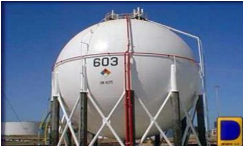
**Figura 4.** Tanque esférico
