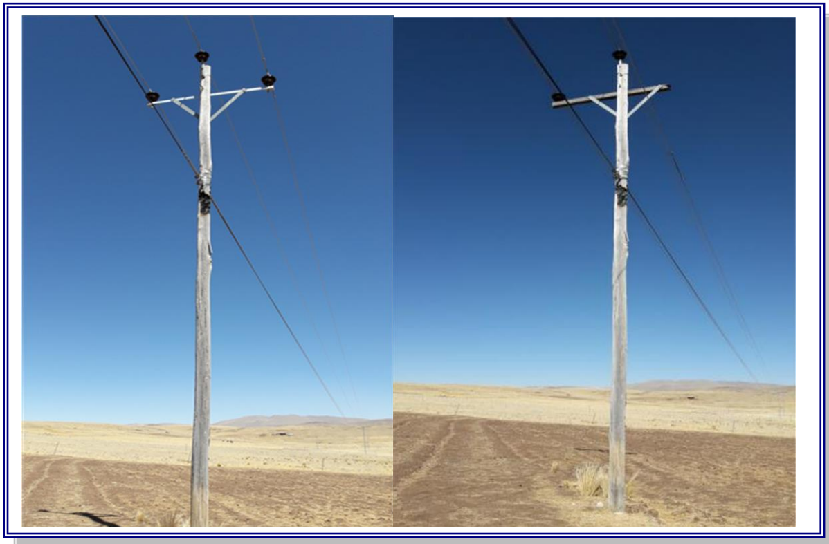
Estructuras deterioradas línea 22.9 KV alimentador 9001
