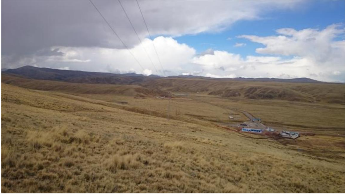
Recorrido de la línea 22.9 Kv alimentador 9001
