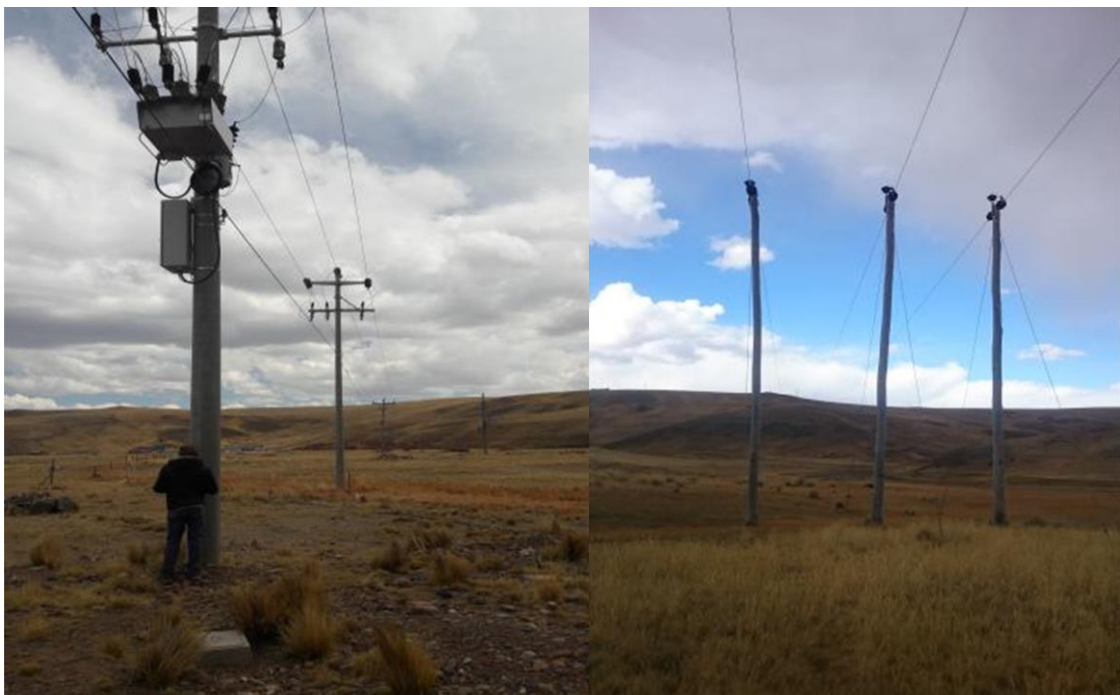
Realizando el Diagnostico de la línea 22.9 Kv alimentador 9001
