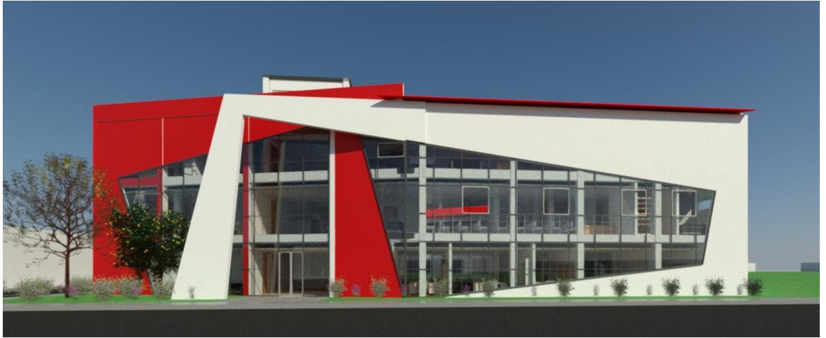
Imagen 32: Fachada principal del proyecto
