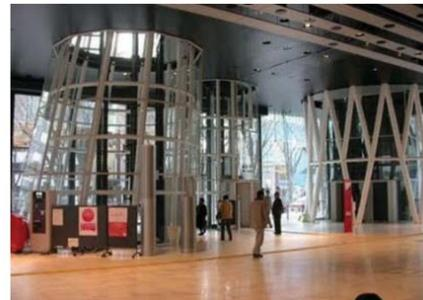
Figura 6: estructura en acero. Mediateca de Sendai, de Toyo Ito
