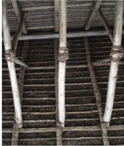
Figura 2: Estructura de caña. Techado construido con técnicas incas
