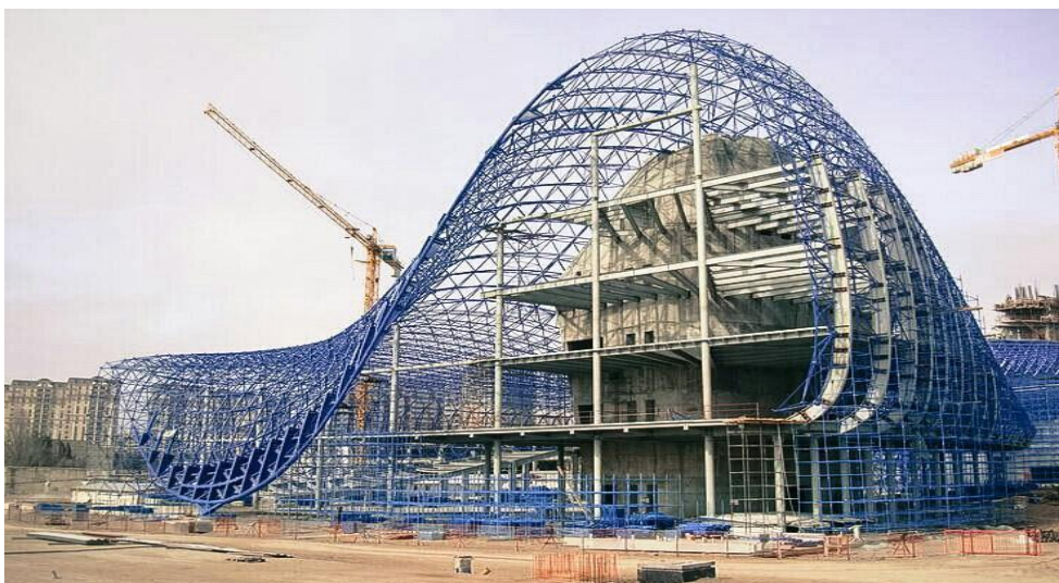
Imagen 40: Geometría paramétrica como solución estructural en la cubierta Fuente: https://es.wikiarquitectura.com/edificio/centro-cultural-heydar-aliyev/
