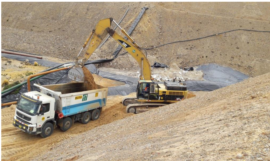
Figura 21. Inicio de carguio de mineral de pad especial zona 1 hacia la zona 11
