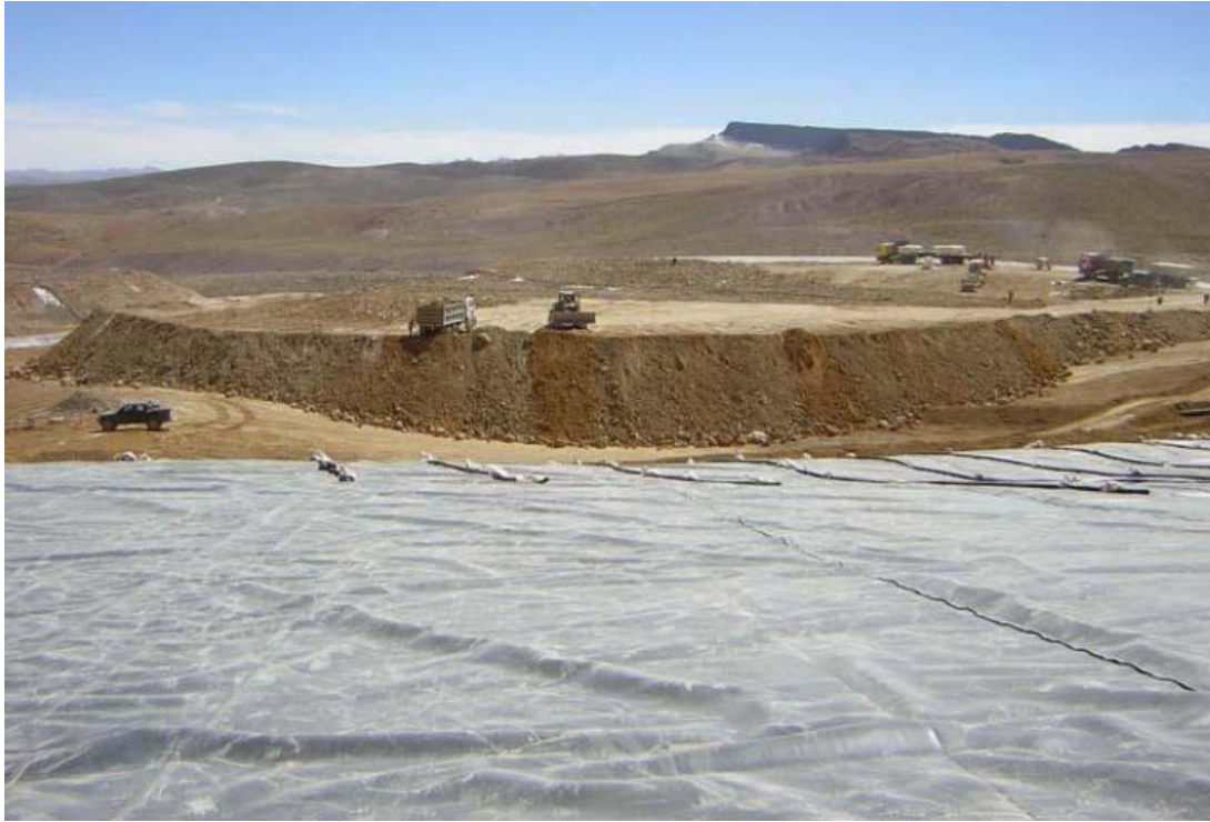
Figura 11. Llenado del Pad de Lixiviación.
