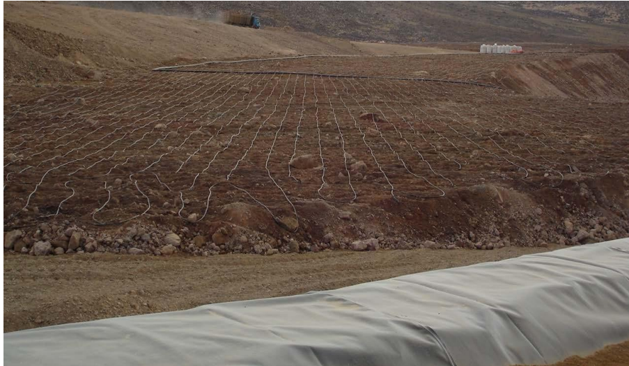
Figura 17. Armado de Celdas de Riego, celda N° 33 Lift 3.
