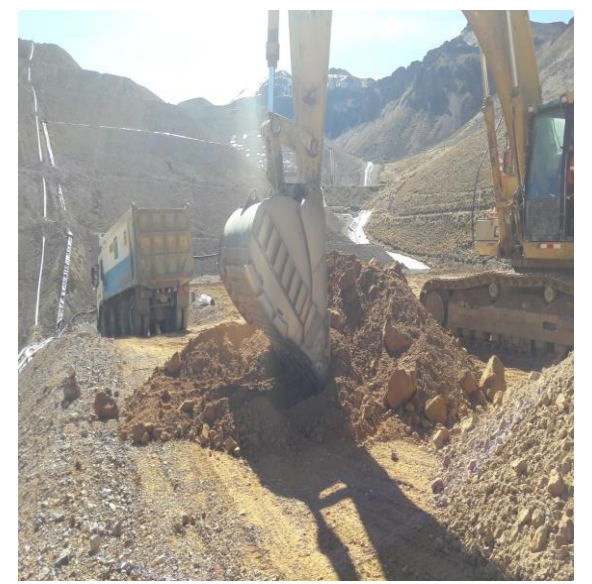
Figura 24. Extracción de muestra de mineral de pad especial zona 1
