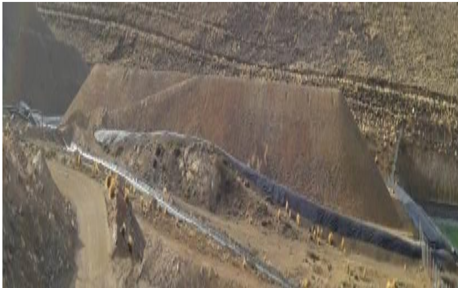
Figura 19. Zonas para la remoción del mineral en Pad Especial de Lixiviación
