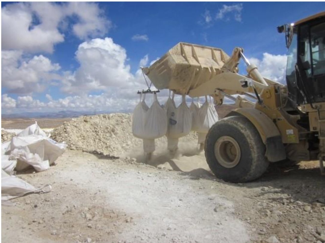
Figura 15. Dosificación de cal, cada bolsa es de 1 tonelada.
