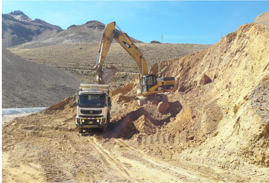
Figura 22. Zona 1 pad especial, retirando el mineral, para luego el material de la zona 2 se mueva a la zona 1.
