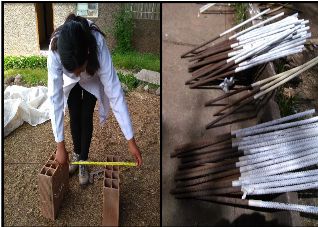
Figura 32. Corte de las varilla de erosión a 50 cm y pintado de las varillas
