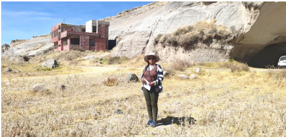
Figura 39. Playa de Chatuma – hospedaje en construcción
