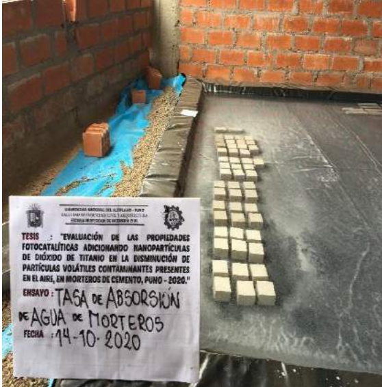
Figura 198: Curado de probetas en poza de curado para ensayo de absorción.
