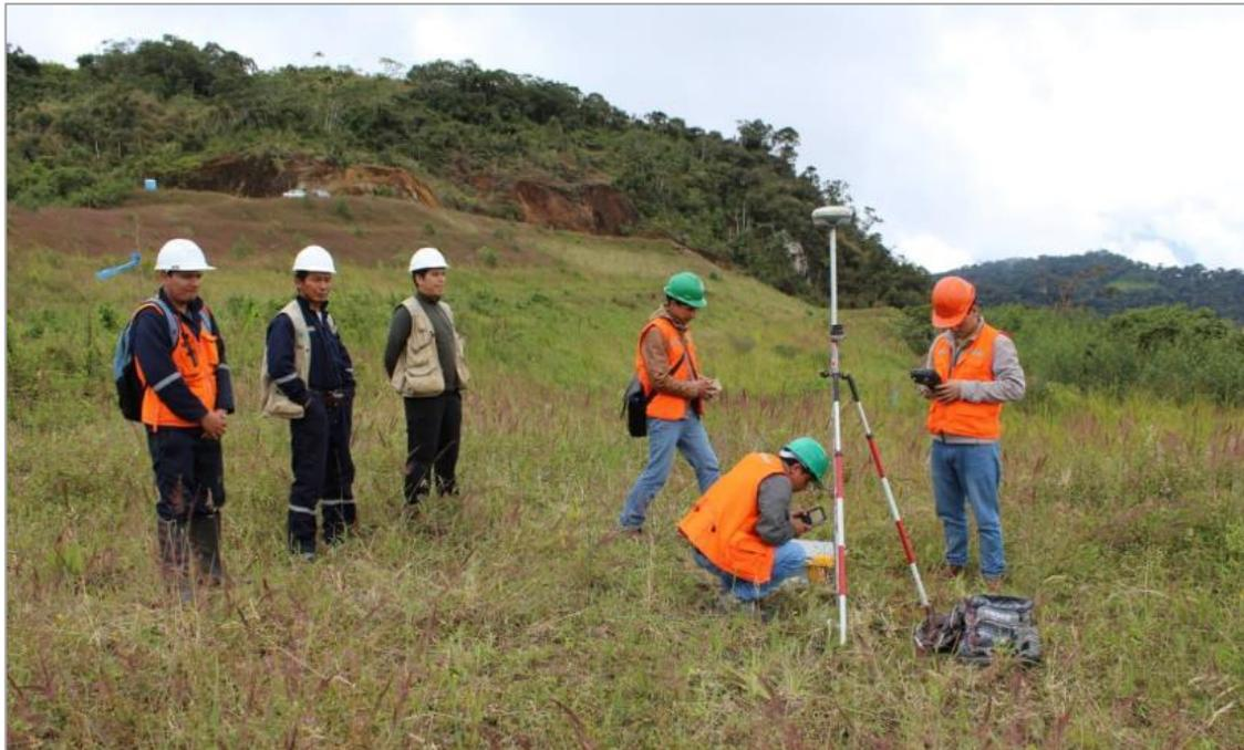
**Figura 34.** Levantamiento topográfico de sondajes históricos en Bongará, previo al programa de perforación.
