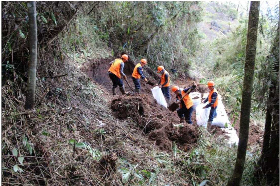
Foto 05: Proceso de construcción de plataformas de perforación en Mina Chica.
