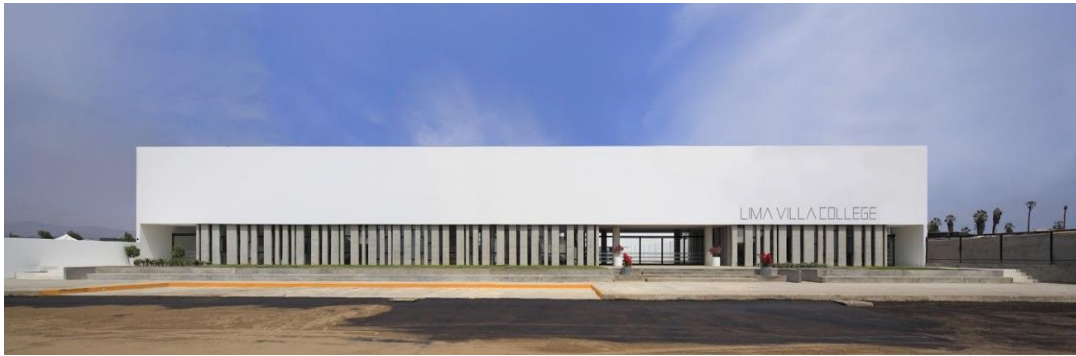
Figura 17: Fachada del colegio. (fuente: Nomena, Bryce, 2013)
