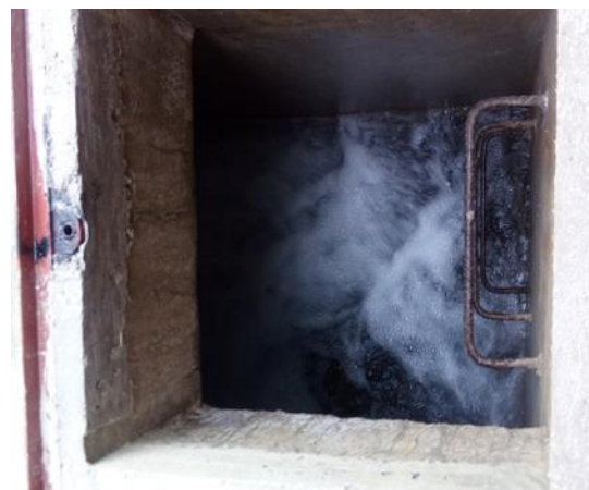
Figura 44. Pozas de agua de captación. agua de la muestra
