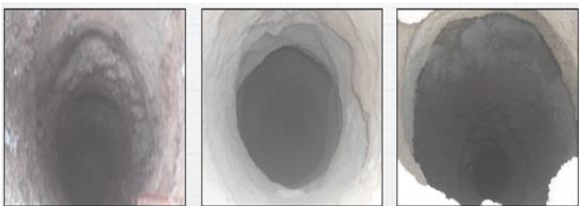
Figura 7: Condiciones de taladro
