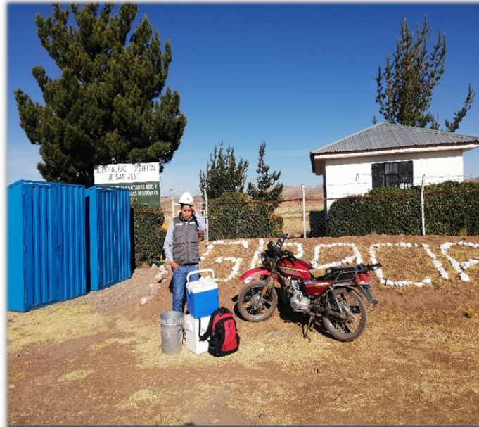
Figura A12. Llegada a la planta de tratamiento de aguas residuales del distrito de san José
