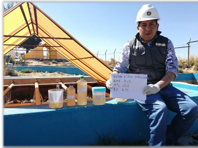
Figura 13. Toma de muestra en la salida del filtro percolador Fuente: Elaborado por el equipo de trabajo
