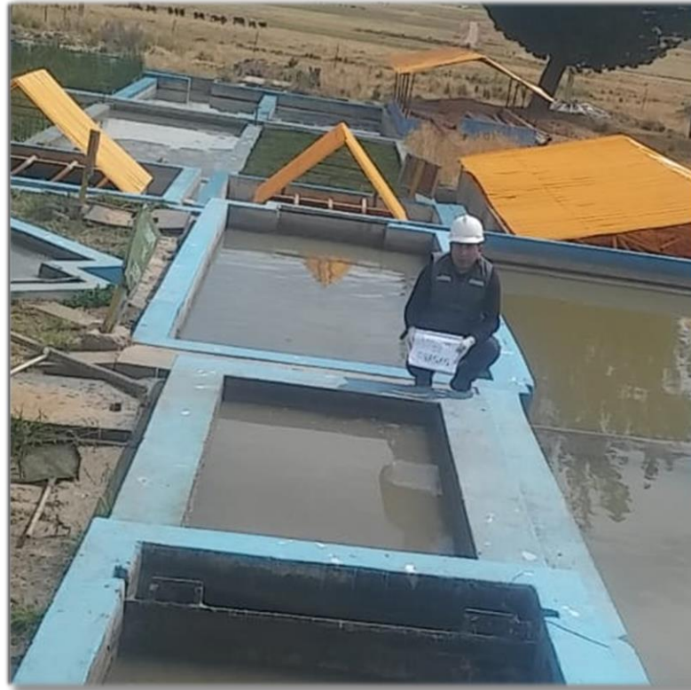
Figura 6. Trampa de grasas Fuente: Elaborado por el equipo de trabajo
