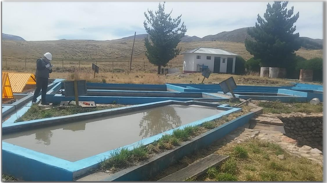
Figura A24. Registro de datos en la PTAR San Jose
