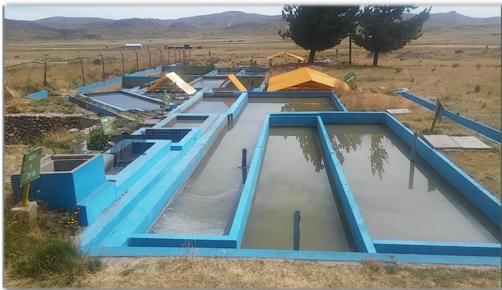
Figura 15. PTAR San José Fuente: Elaborado por el equipo de trabajo
