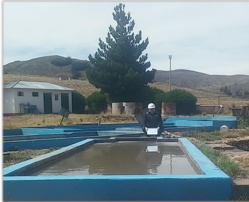
Figura 7. Sedimentador 1
