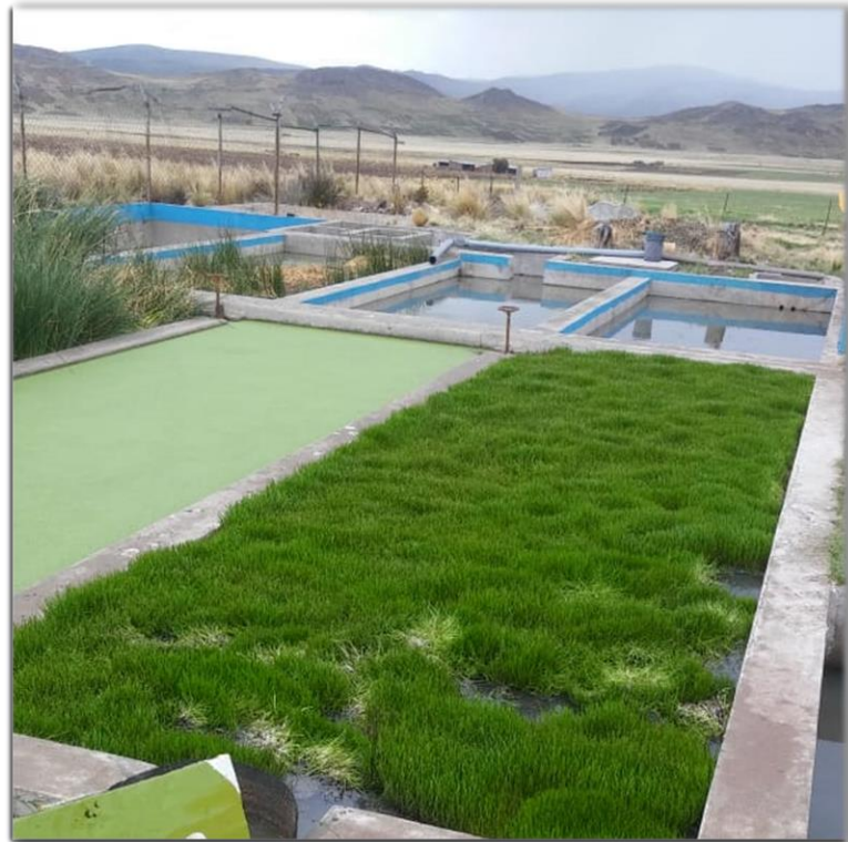
Figura 11. Humedales artificiales Fuente: Elaborado por el equipo de trabajo
