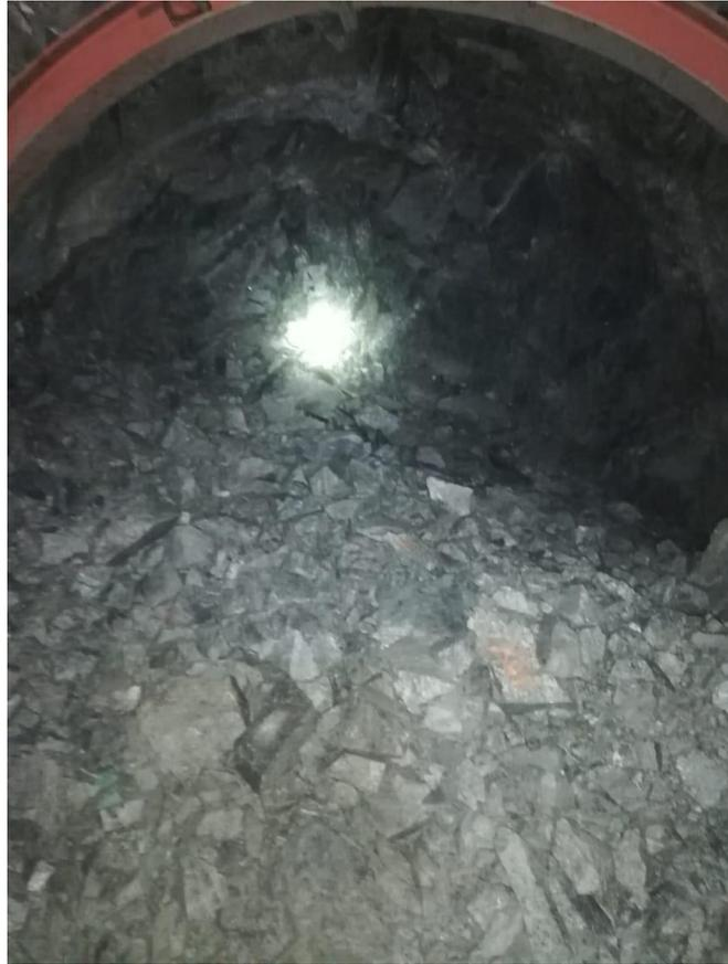
**Ilustración 6:** Vista del tamaño de los fragmentos en la voladura propuesta
