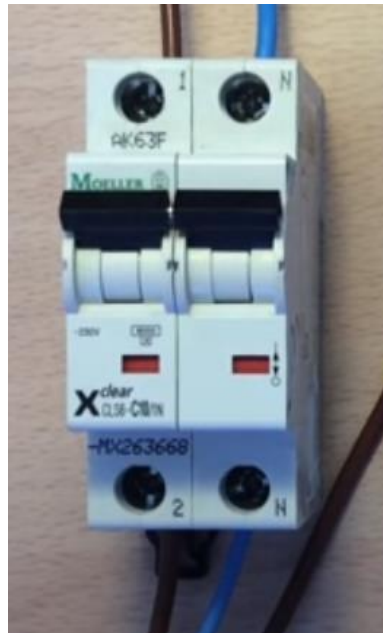
Figura 3.5: Interruptor termomagnético, monofásico, Tipo AC Elaborado por el equipo de trabajo
