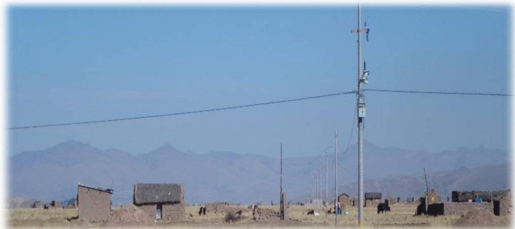
Fotografía N° 03: Electrificación en el distrito de Huata
