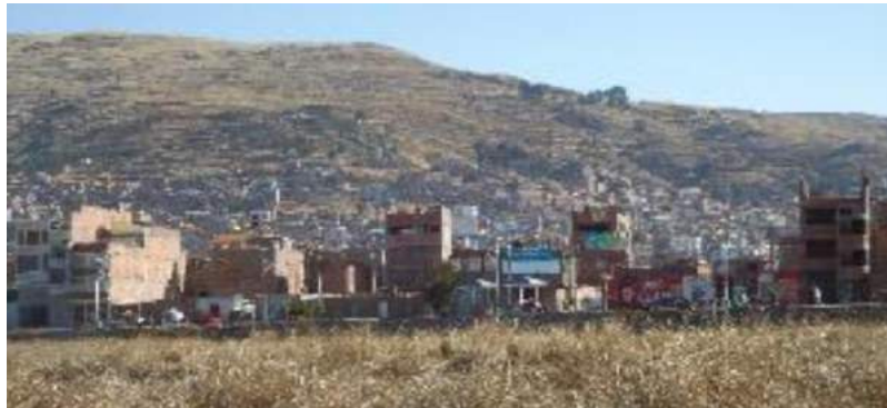
Imagen 97: Perfil urbano Av. Costanera. FUENTE: Elaborado por el equipo de trabajo.
