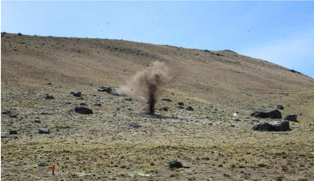
Figura 23. Voladura con explosivos de emulnor (Famesa)
