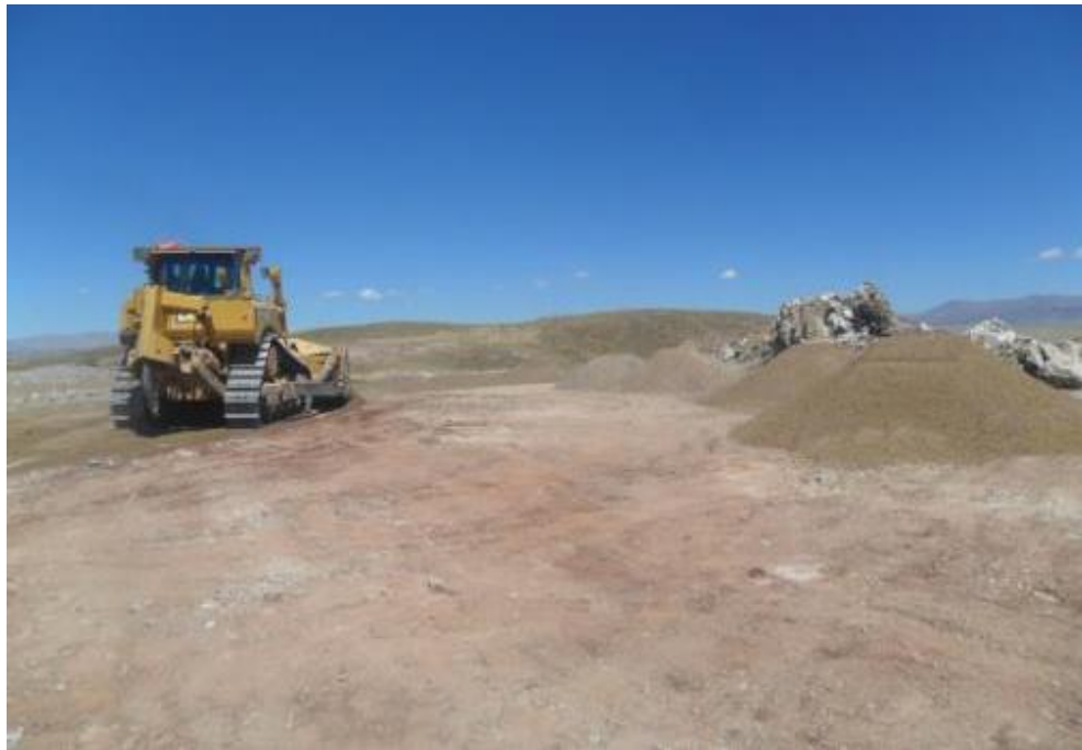
Figura 14 Tractor realizando nivelado de plataforma de perforación
