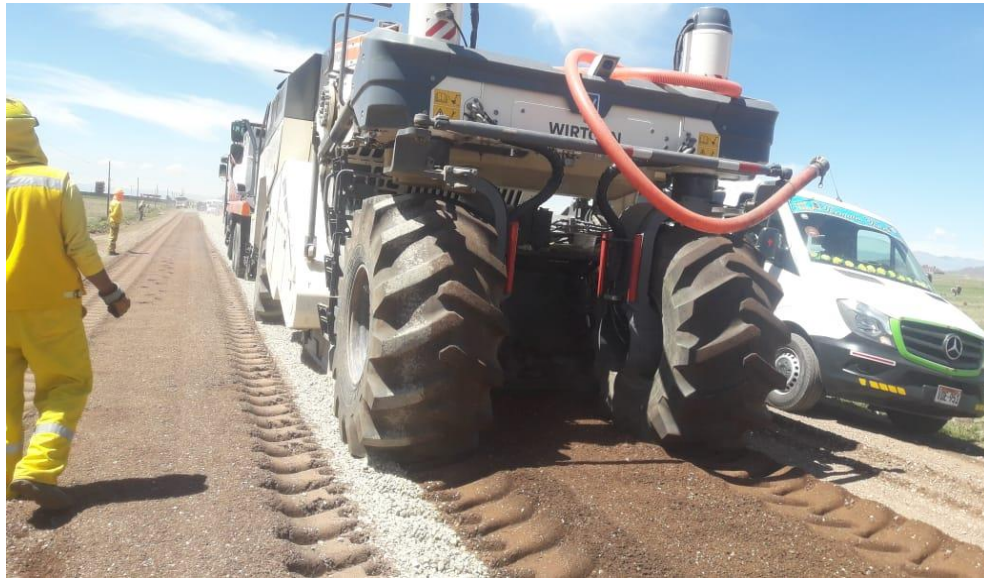
Figura 11: Escarificado utilizando la maquina recicladora.
