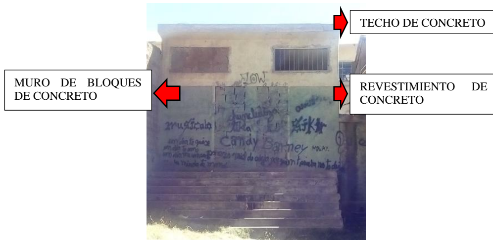
Figura 86: Fotografía de la fachada este de los servicios higiénicos.
