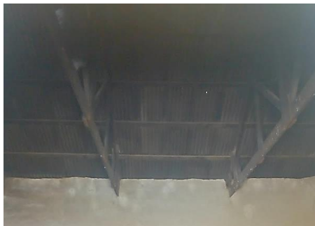
Figura 78: Fotografía de estructura de la cubierta de calamina del galpón- carga
