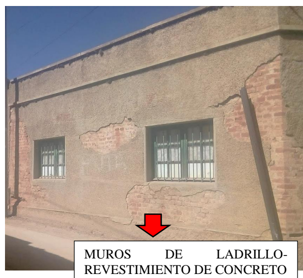
Figura 80: fotografía de fachada norte (materiales)
