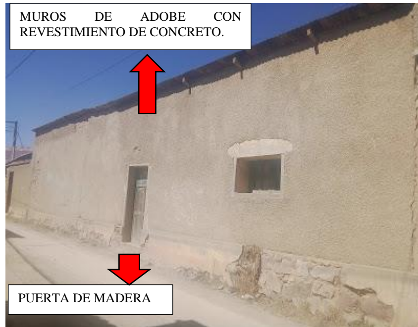
Figura 81: Fotografía de fachada norte de la vivienda peón tráfico 01 y estanquero 02. (Materiales).
