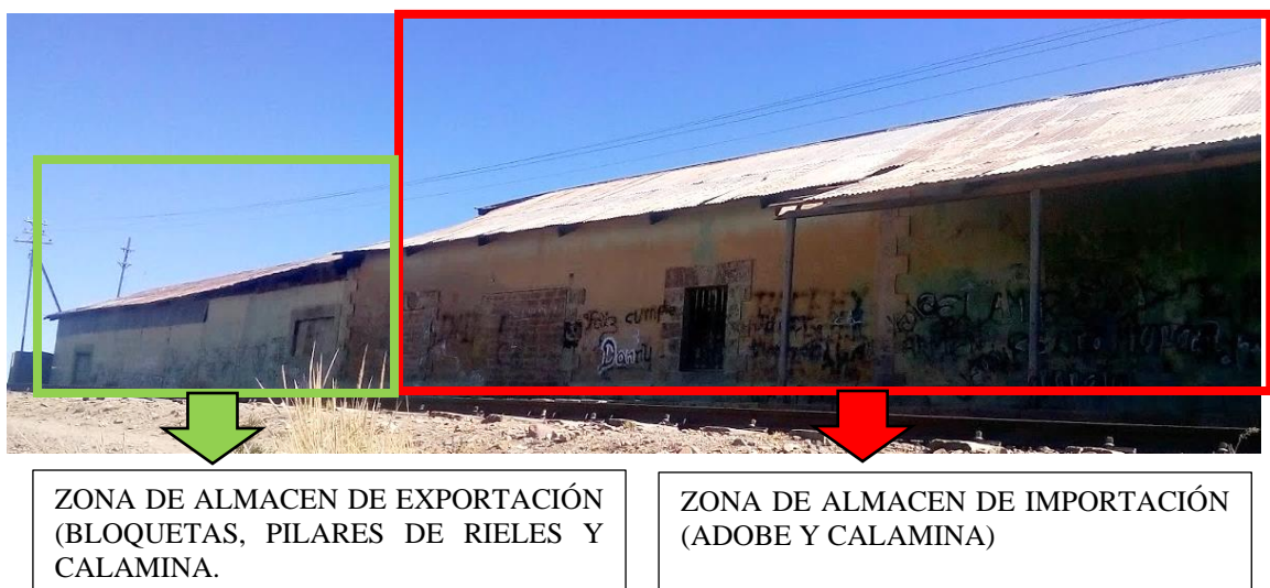
Figura 75: Fotografía área de galpón- carga (materiales)
