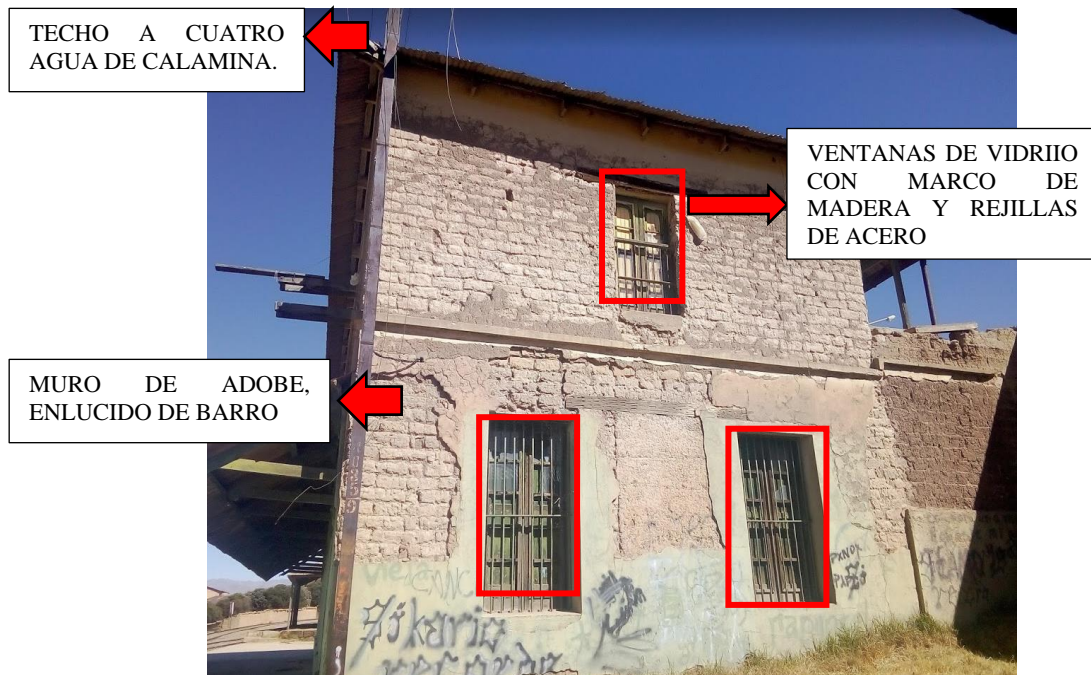
Figura 84: Fotografía de fachada norte del edificio estación-(materiales)
