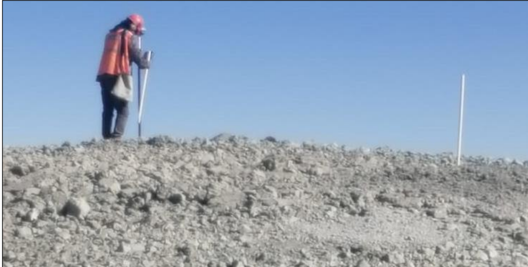
Figura 6. Topógrafo colocando estacas
