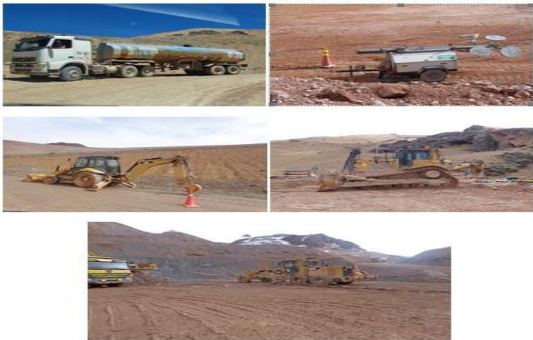
Figura 19. Cisterna de agua, luminaria, retroexcavadora, tractor y motoniveladora
