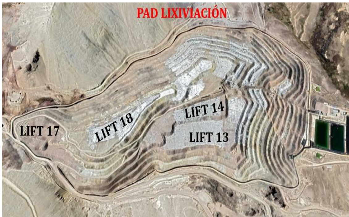
Figura 60. Vista satelital del pad lixiviación
