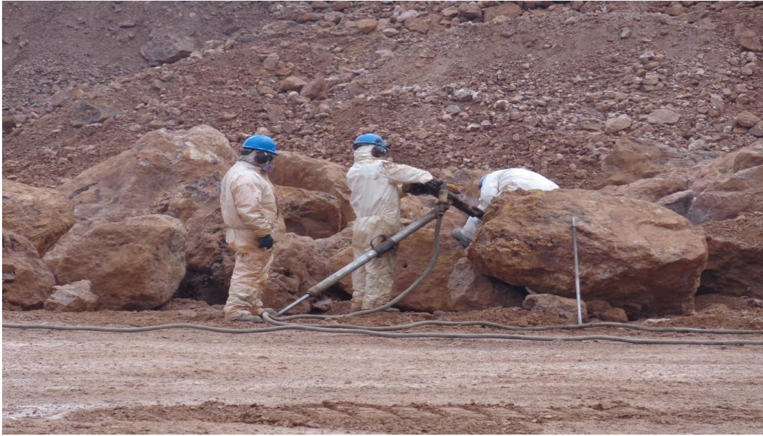
Figura 8. Perforación secundaria con jackleg
